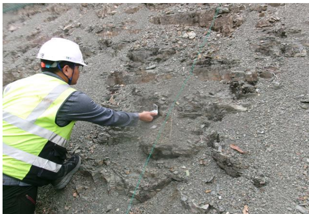
절리면 경사/경사방향 측정
