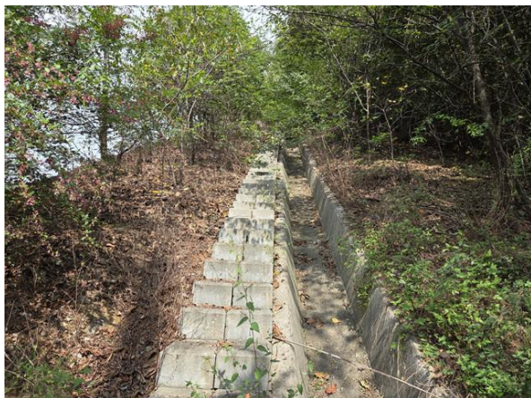
산마루측구, 점검계단 전경
